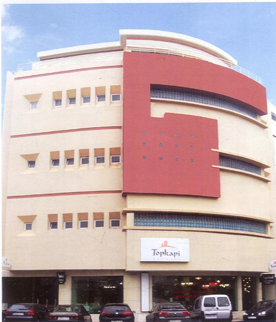
Façade du hammam dans le quartier Gauthier.
